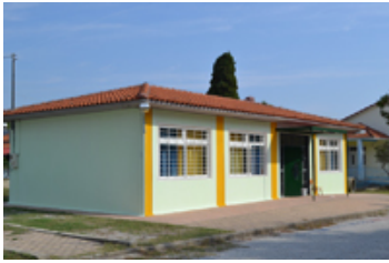
Το Λυόμενο κτίριο της Α΄ τάξης.
